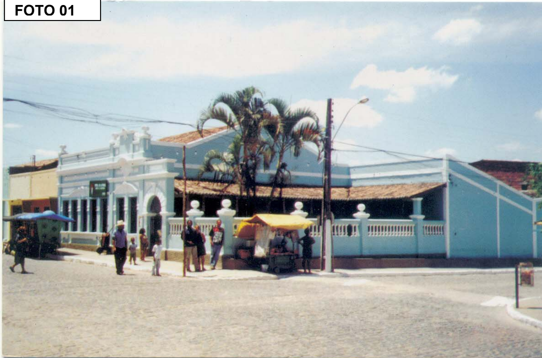
ARQUITETURA DO CASARIO DE BARRA DE GUABIRABA, NO CENTRO DA CIDADE
