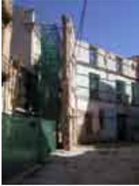
**Mantenimiento de una fachada en el casco histórico de Málaga tras la demolición completa del interior.**
