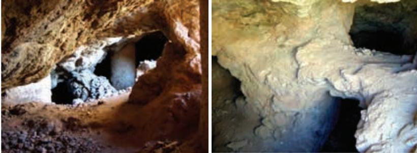
VILAS MINONDO, LORENZO Figura 3.- Sala con pilares. Obsérvese el deterioro del pilar central producido por los buscadores de minerales.
