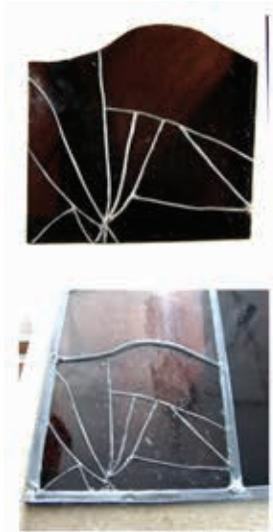
FOTO 7. Fuente: Fernando Cortés Pizano. Nota a pie de imagen: Proceso de restauración de fracturas en una pieza de vidrio mediante cinta de cobre.
