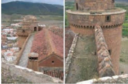
Habría que destacar que para la construcción de este edificio, han sido aprovechados buena parte de los materiales de las antiguas edificaciones árabes, esto es así porque quedan restos de antiguas construcciones junto a la muralla defensiva en el lado noreste. (figura 1.1.7.)
