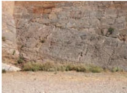
*Fig. 1.1.16.. Apoyo en la fachada sur de los sillarejos en el estrato*
