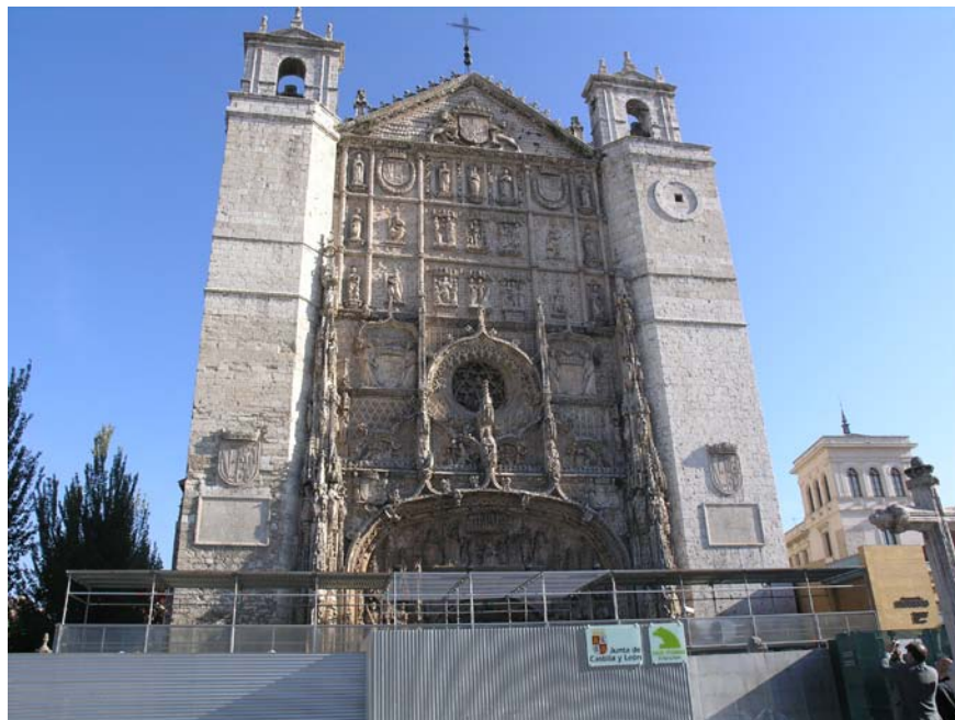
Restauración de la fachada de la iglesia del convento de San Pablo (Valladolid). Fundación Caja de Madrid
