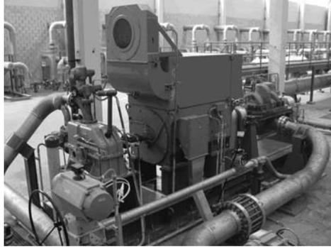
Figura 9. Tren turbobomba con turbina de recuperación tipo pelton.
