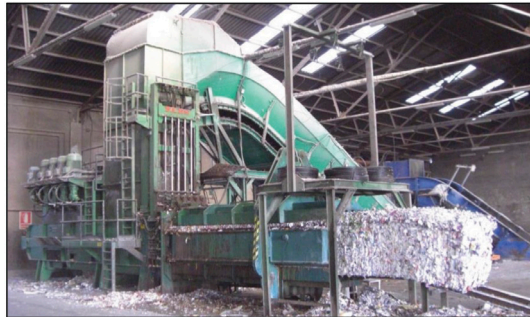
Figura 17. Funcionamiento de la planta de clasificación PyC
