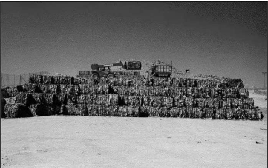
Figura 7.3. Colocación de balas de alta densidad (IMABE, 2007).
