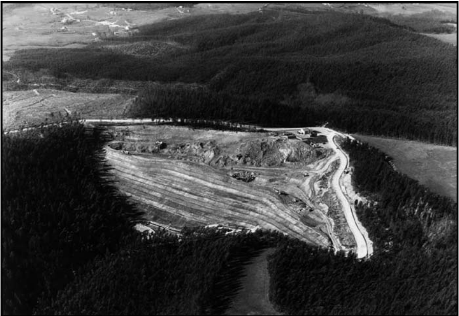
Figura 2.7. Vertedero sanitario controlado de Meruelo, Cantabria, España. (Szantó, 2006).
