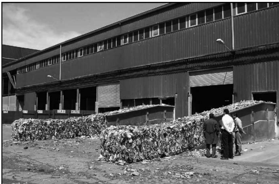
Figura 7.1. Planta de tratamiento de residuos sólidos de Meruelo, España. (IMABE, 2007).
