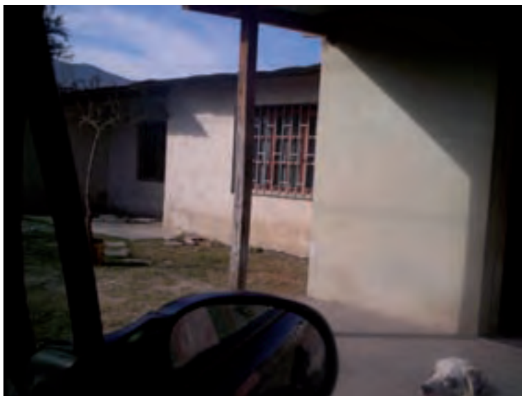
Figura 55: Fotografía vivienda Barrio El Sol (obsérvese que las paredes se encuentran revocadas, las carpinterías son de madera y poseen rejas).
