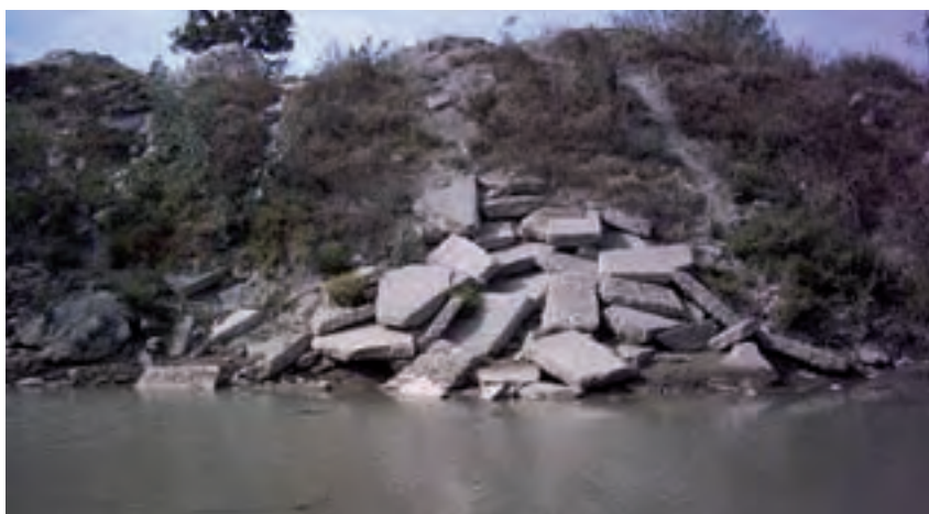
Figura 10: Fotografía ocupación sobre material de relleno y escombros en la ribera sur.
