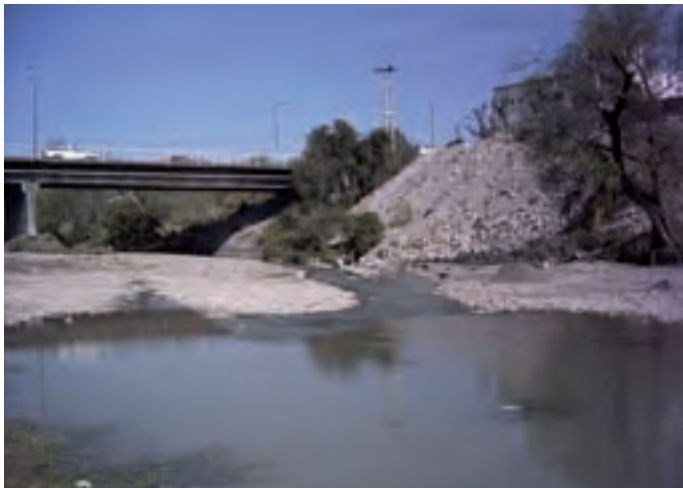
Figura 78: Fotografía Margen Sur, al lado del puente de Av. Chile, se observa un importante vuelco de escombros que estrangula en parte el cauce del río.
