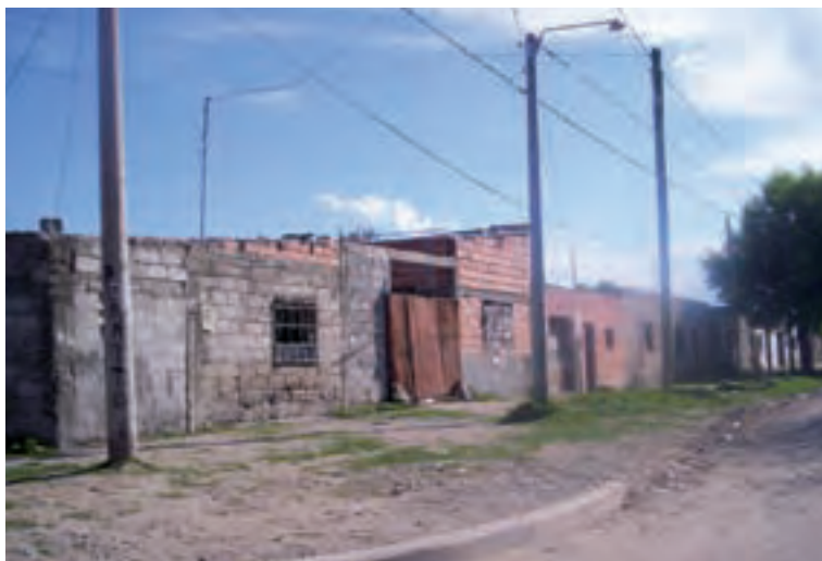
Figura 51: Fotografía cordón cuneta y pavimentación (intersección calle Córdoba y una de las calles laterales).
