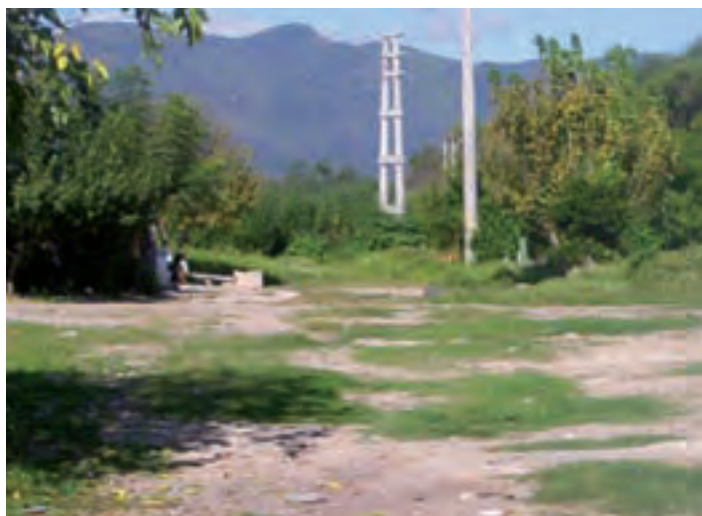
Figura 76: Fotografía interrupción de Avenida Costanera norte por asentamiento poblacional (Ceferino).
