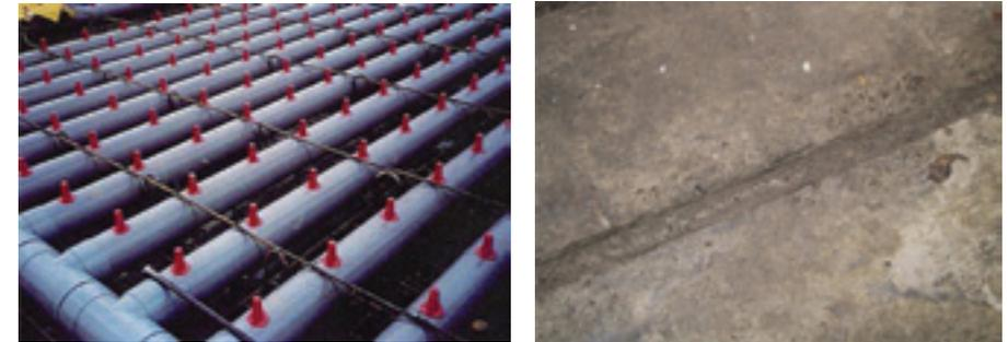
Figura 3.12. A la izquierda, suministro de aire en el suelo de un túnel en construcción (sin cubrir) y a la derecha, detalle de suelo perforado del túnel (ya cubierto).
