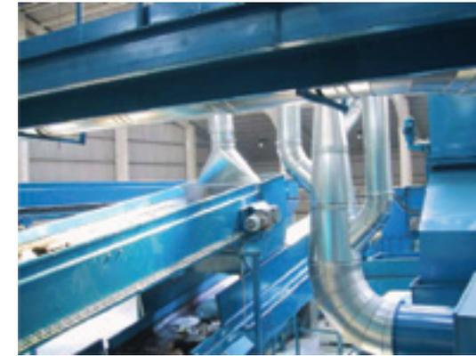
Figura 3.5. Aspecto de los conductos de aspiración que garantizan la calidad del aire dentro de la planta de Compostaje.
