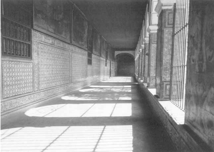
Fig. 6.- Galería del claustro del convento de San Francisco de Lima.
