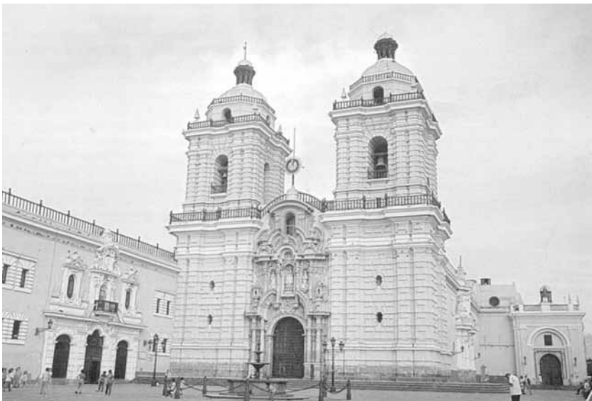
Fig. 4.- Fachada principal de la iglesia conventual de San Francisco de Lima.
