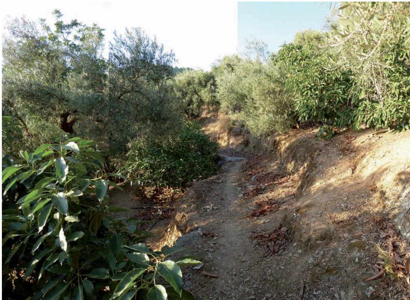
V4. Camino sobre la acequia del Hambre cubierta, a ambos lados se combinan aguacates con olivos, en este caso se riegan por inundación. Los muros de piedra no se están manteniendo y hay una fuerte erosión del suelo.
