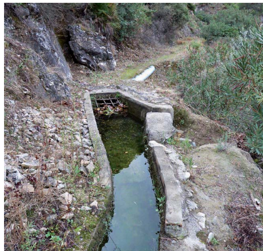
Punto donde se entuba y se cubre la acequia.
