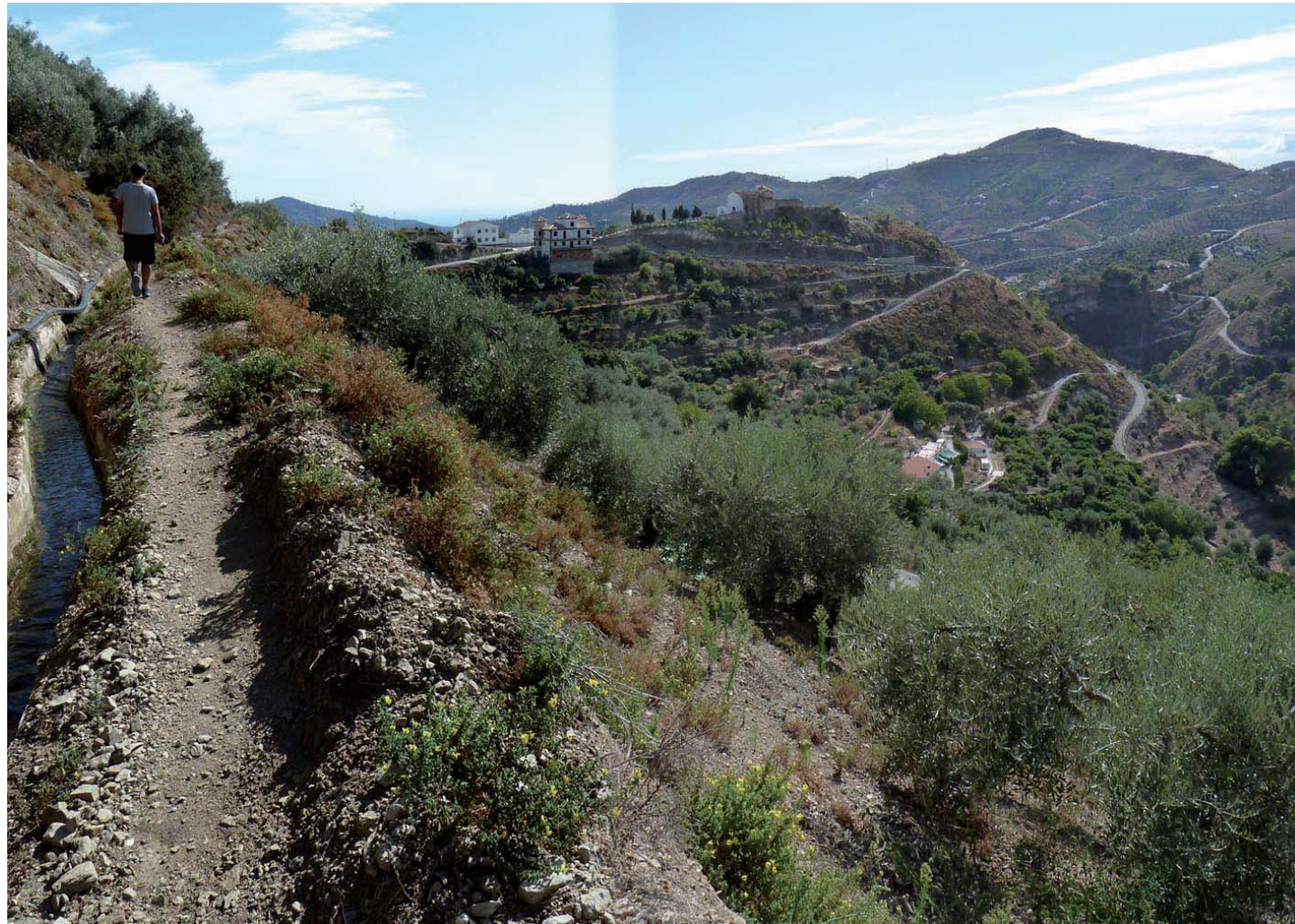
V7. A la izquierda transcurre la acequia Real, una parte del caudal está entubado y la otra sigue discurrendo por el canal al aire libre; al fondo la parte alta del pueblo de Canillas de Albaida y la ladera labrada con terrazas de cultivo de pequeñas parcelas de olivos, aguacates, algunos naranjos...
