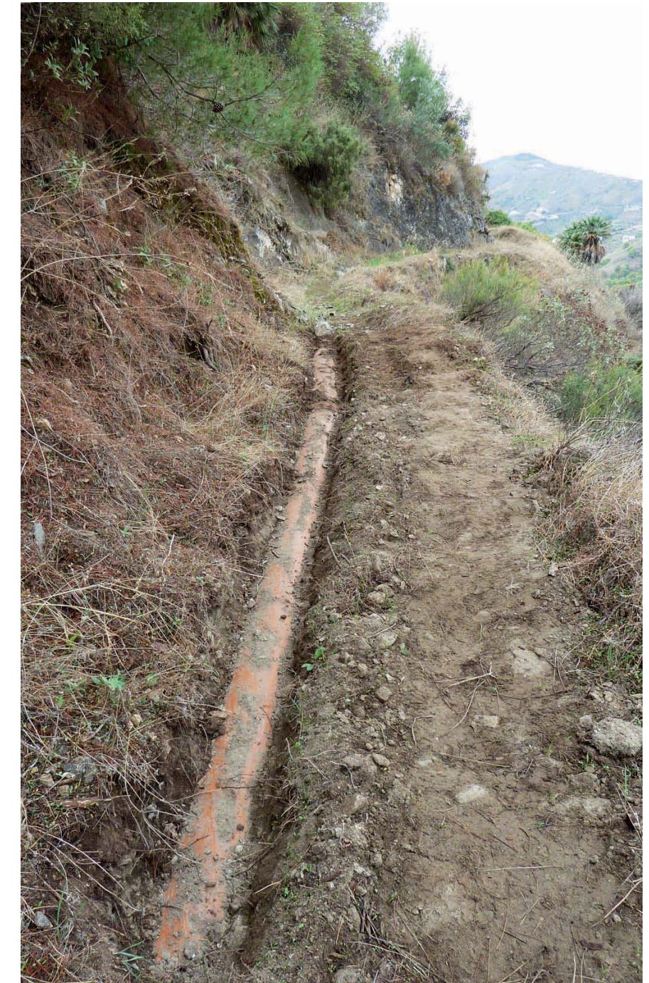
Tramo de acequia entubada y cubierta, está la tubería visible porque se tapó y se tuvo que revisar.
