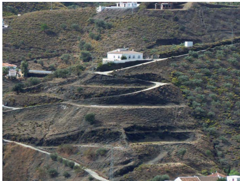
V1. Ejemplo de la nueva "filosofía" y técnica de roturar el suelo, en este caso se ha utilizado la tierra para construir un camino para vehículos, parece ser que partiendo o limitando una antigua parcela de cultivo en pendiente, y dejando, fruto del movimiento de tierras con maquinaria, el suelo descubierto sin muros de piedra y por lo tanto, con una importante erosión del suelo. Al lado, un ejemplo tradicional de cultivo en secano y pendiente de viña y olivos.
