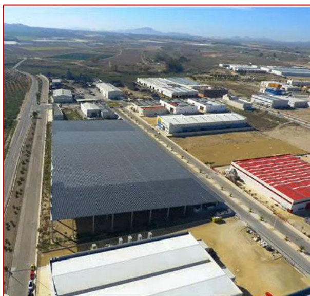
Fotografía 7. Ejemplo de cubierta solar para naves industriales en Alhama de Murcia, desarrollada por la empresa inmobiliaria GET con 2,9 MWp de potencia instalada.
