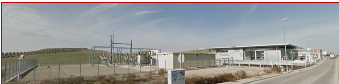
Fotografía 6. Subestación Vaciacostales junto a la ubicación 1, Concesionario Savoy.
