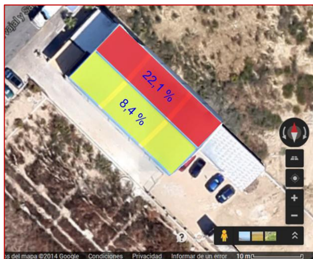
Ilustración 39. Ubicación 18. Pérdidas por orientación e inclinación.
