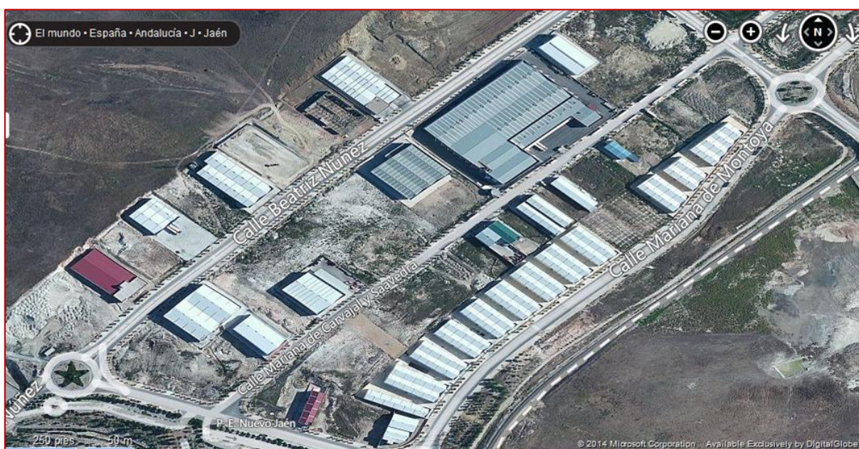
Fotografía 2. Vista parcial del Parque Empresarial Nuevo Jaén. Las cubiertas no se orientan hacia el sur. El parcelamiento y el trazado de los viales está realizado siguiendo la dirección de las vías de comunicación anexas, ferrocarril y carretera N-323
