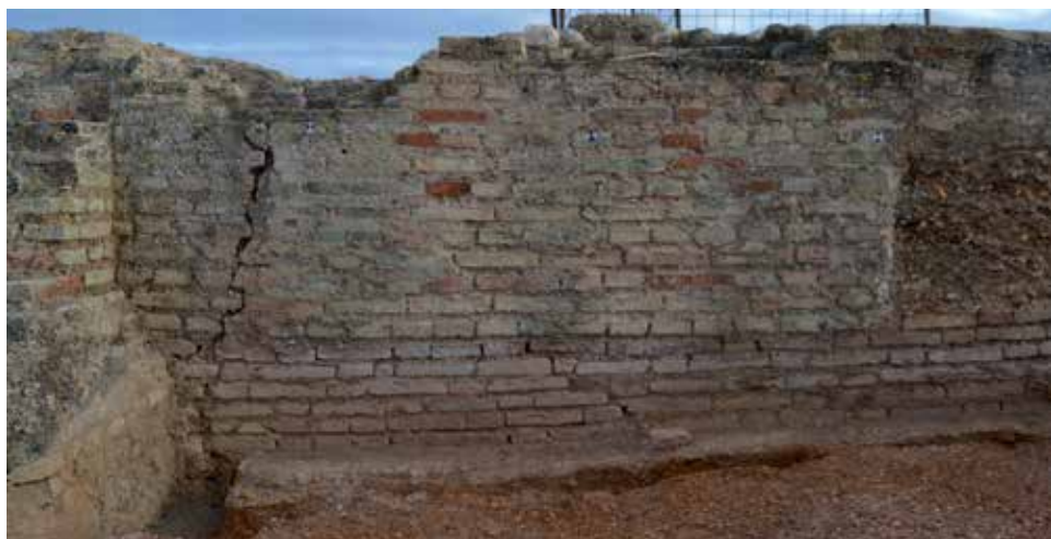
Figura 12. Refuerzo latericio dispuesto en el lienzo septentrional para el encastrado de la torre noreste.
