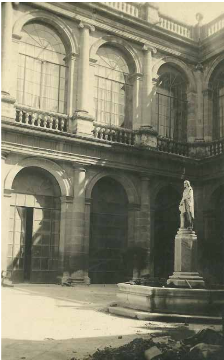
Fig. 1. Fuente de Cristóbal Colón en el patio de la Casa Lonja de Sevilla, sede del Archivo General de Indias.
