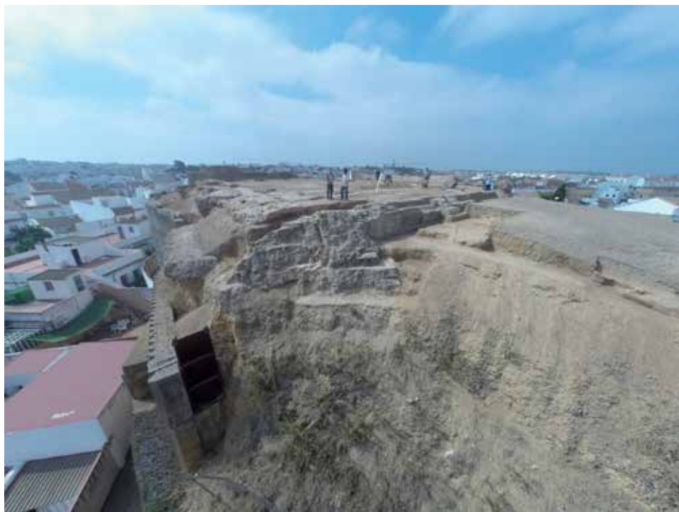
Figura 11. Fotografía de los dos sistemas de cimentación achaflanados de la torre noreste.
