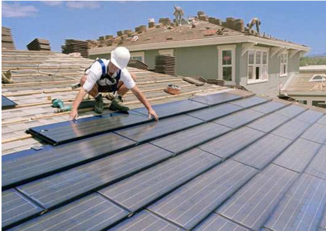
Fig 2.21 Instalación de paneles de capa fina sobre tejado
