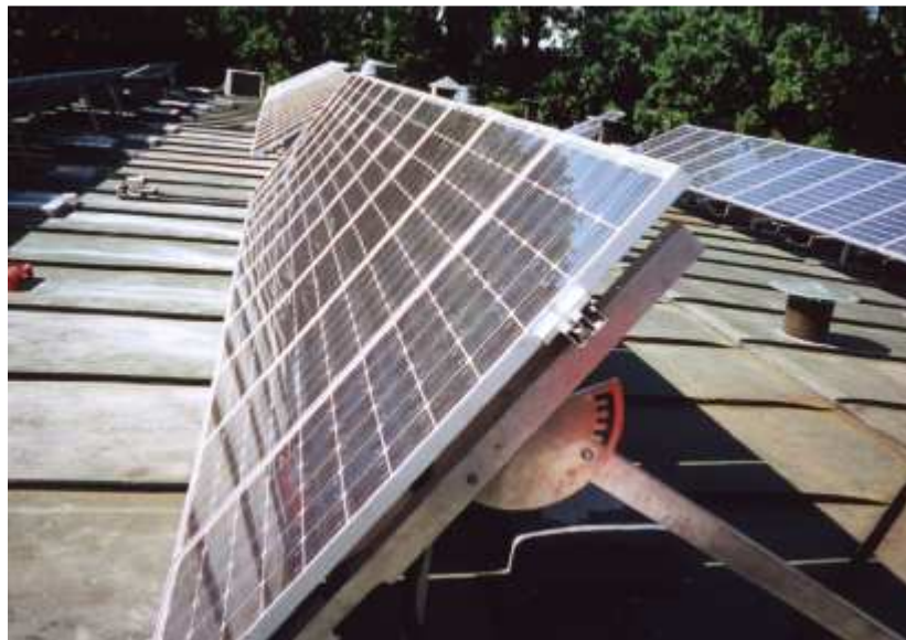
Fig 4.34 Estructura VarioTop de Schletter, adaptable desde 10^\circ a 60^\circ (fuente 48)
