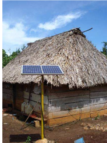
Fig 2.14 Sistema fotovoltaico autónomo para una cabaña
