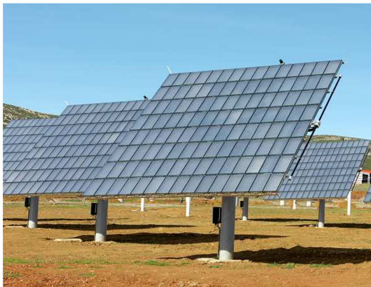
Fig 2.23 Seguidores con módulos FLATCON de la compañía Concentrix (fuente 20)
