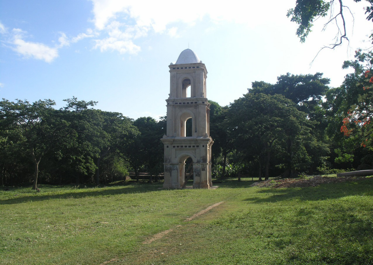
Imagen 6. Hacienda San Isidro de los Destiladeros. Valle de los Ingenios (Cuba). Fuente: Archivo personal.
