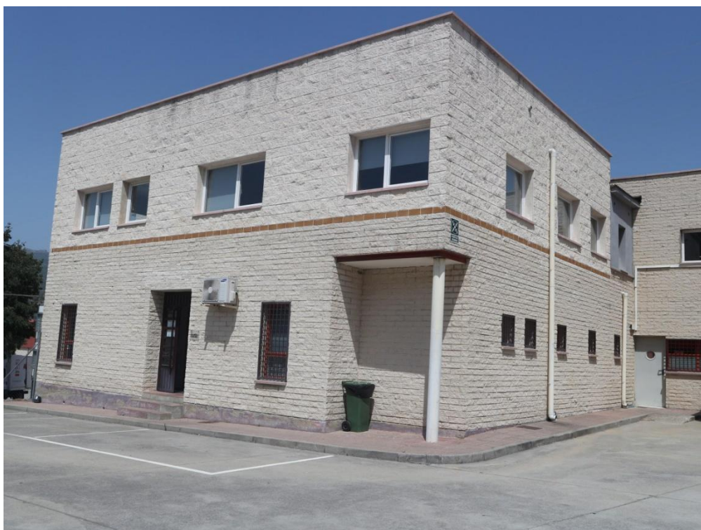
Imagen 9. Edificio de oficinas de la Agrupación. Valdestillas. Imagen propia.
