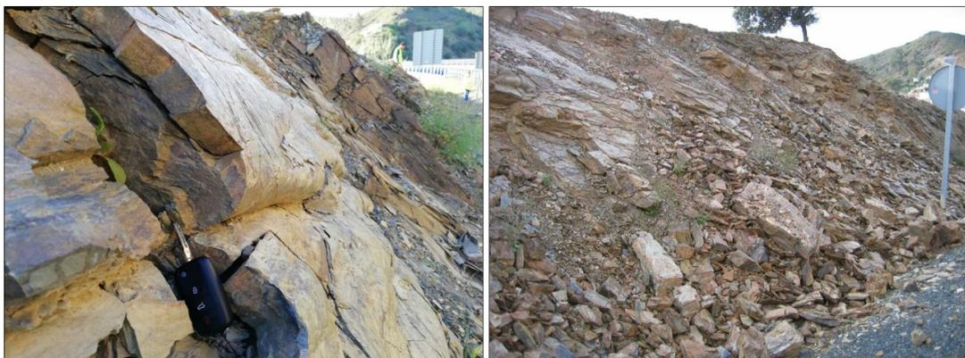
**Figura 4.36.** Talud en trinchera 3 ubicado al frente del talud reforzado, se observa la  $S_0$  replegada. En la foto de la derecha se muestran las inestabilidades presentes en el talud
