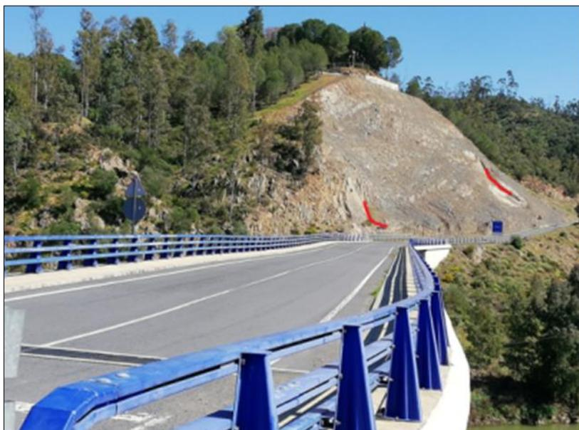
**Figura 4.34.** Sinformes presentes en el talud 3 por los que han ocurrido deslizamientos
