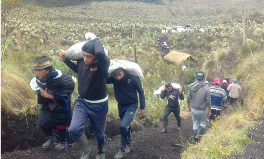
Foto 16: Minga de ingreso de material para mejoramiento de la infraestructura de las piscinas
