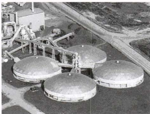
Figura 10: Contenedores circulares agitados
