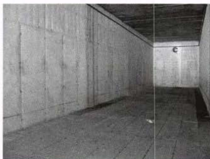
Figura 15: Túnel desde la puerta de carga-descarga
