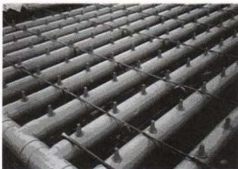
Figura 20: Suministro de aire en el suelo de un túnel en construcción sin cubrir y detalle de suelo perforado del túnel
