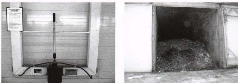
Figura 17: Puerta hermética de un túnel y vista de túnel lleno desde puerta de carga
