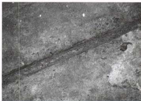
Figura 20: Suministro de aire en el suelo de un túnel en construcción sin cubrir y detalle de suelo perforado del túnel
