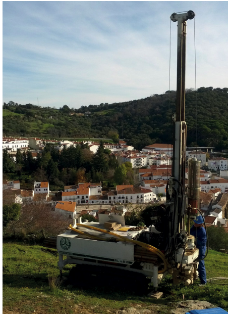
Figura 43: Equipo de perforación Rolatec RL 48-M localizado sobre la vertical del sondeo.
