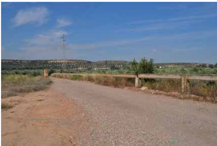
Figura 3: Acequia perpendicular al cauce del río y camino de servicio paralelo en el sector II de la Zona Baja de Vegas del Guadalquivir. Fuente: autores
