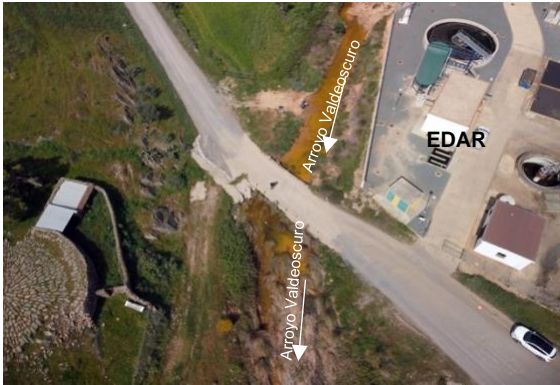
Figura 7. Área de muestreo en el Arroyo Valdeoscuro (MJ1) ubicado junto a EDAR y área de Muestreo en el Arroyo Valdeoscuro (MJ2) ubicado a la salida de EDAR.
