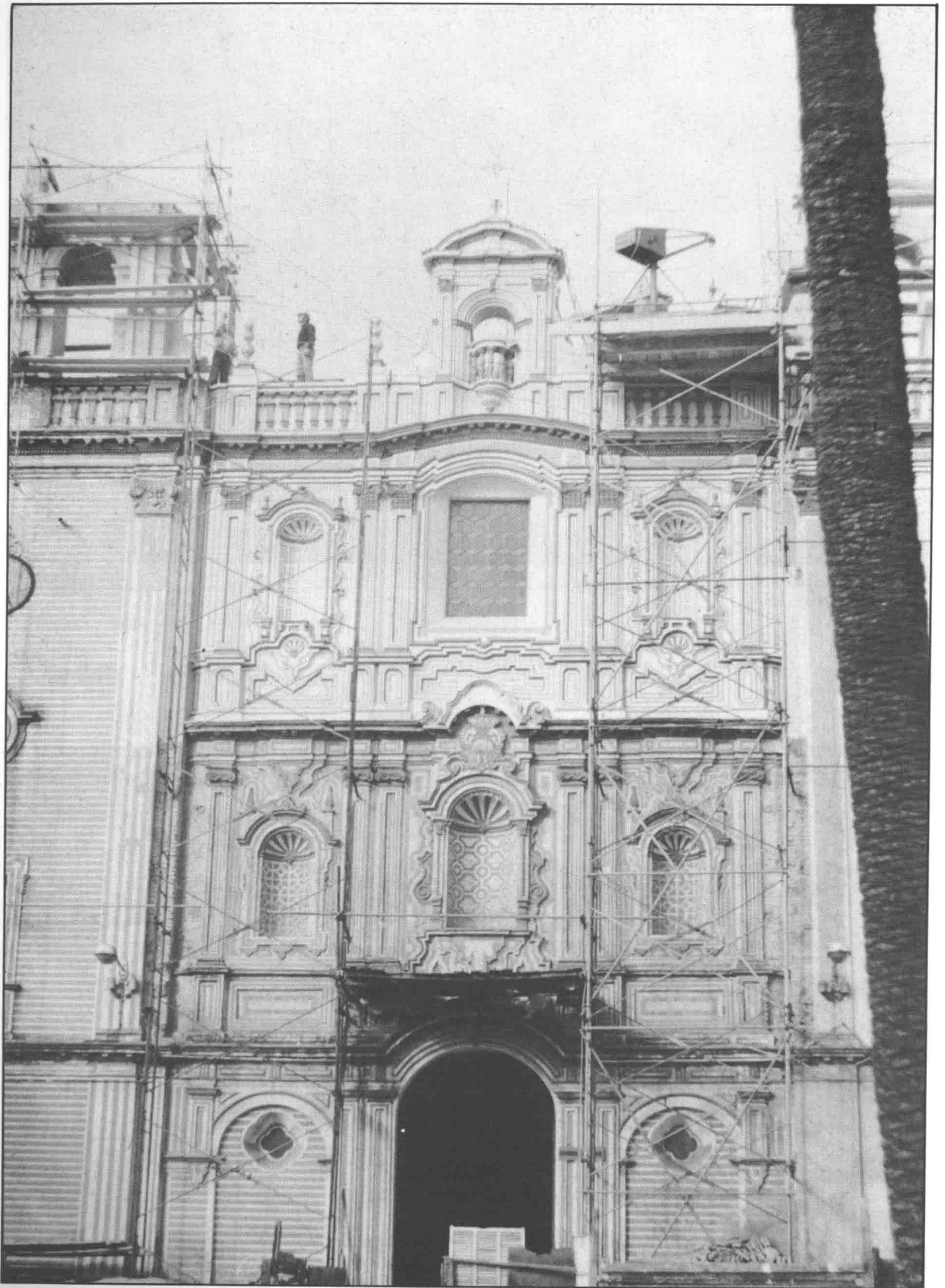
7. Construcción de las espadañas en 1976.
