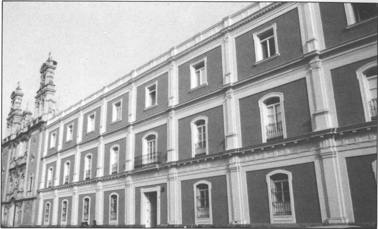
1. Vista general del conjunto.
