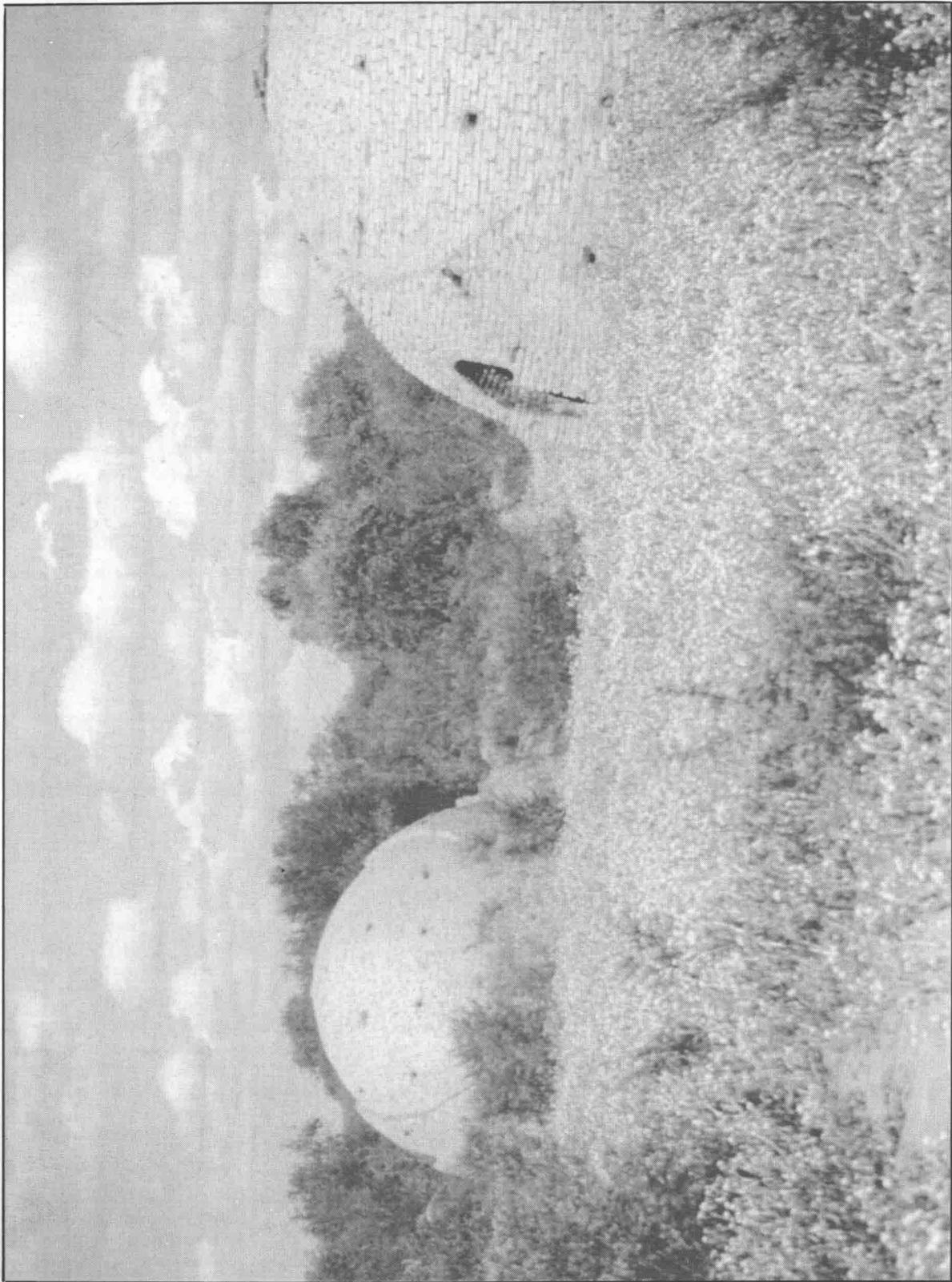
Catamarca (Argentina). Dos ejemplares de hornos para el carboneo con los elementos necesarios para su manejo, puertas, orificios y escalerillas.
