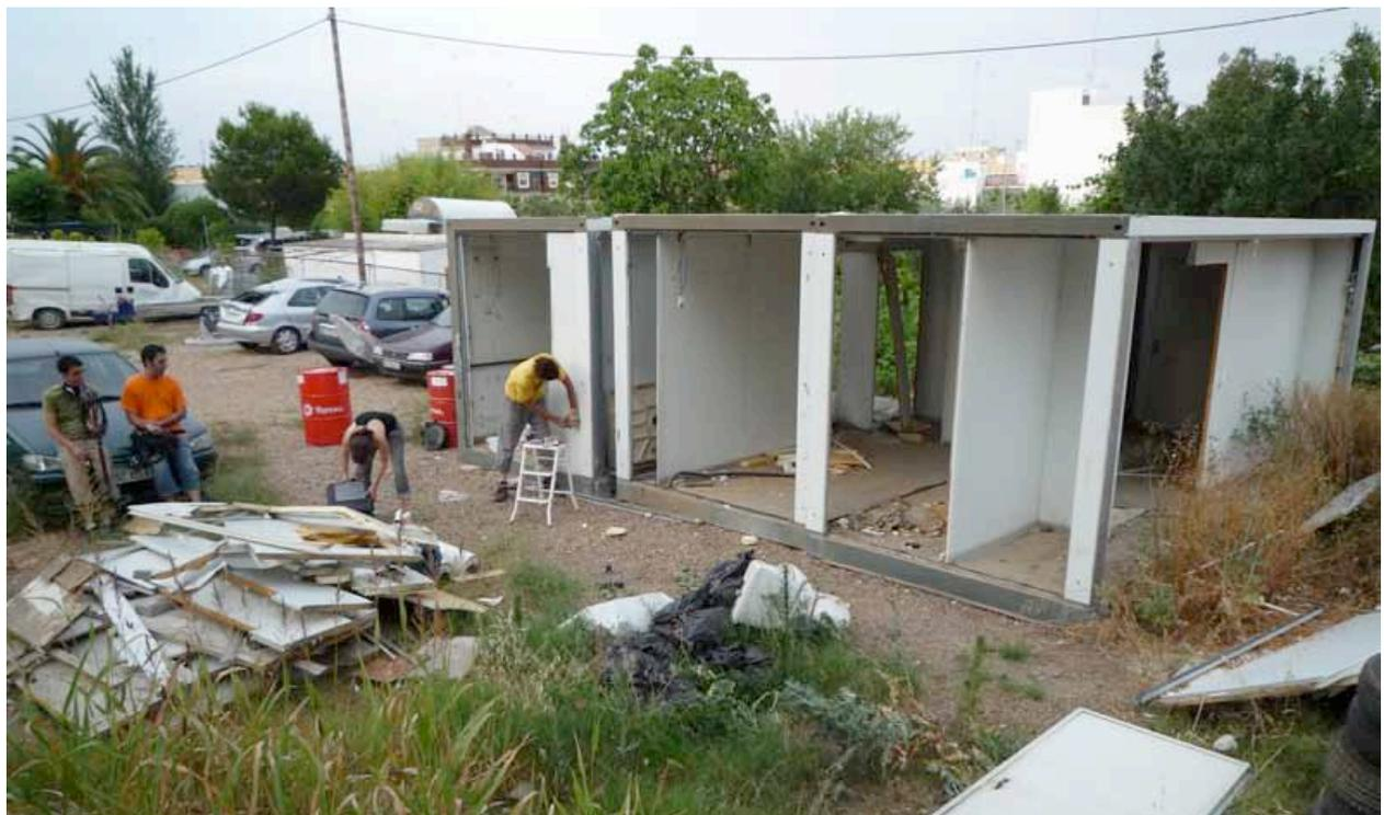
*Ilustración 31: Fase de limpieza y preparación para el desplazamiento (Sevilla)*
