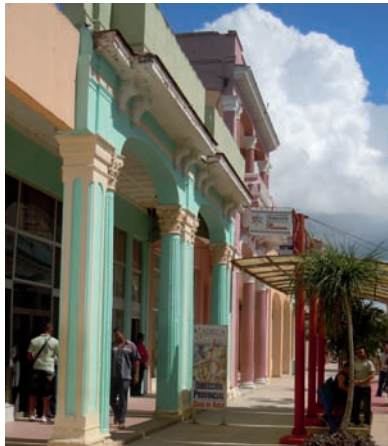
13. El tipo de arquitectura avileña se caracteriza por los soportales y el estilo ecléctico. Bulevar de Ciego de Ávila. Fotografía del autor.
