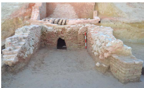
Figura 10. Pasillo y fachada de acceso a la caldera delimitado por los dos contrafuertes donde se aprecian sus diversas reformas.
