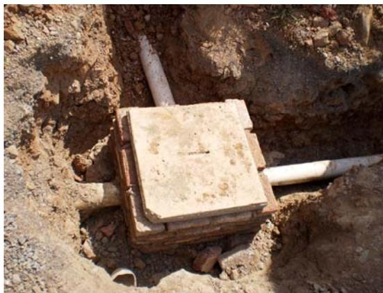
Fig.7. Conexiones a través de las cámaras de registro de la red de alcantarillado.
