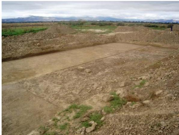
Los humedales pueden ser construidos excavados en el terreno o elevados. En ambos casos será necesario realizar replanteo de la ubicación de los humedales y demás elementos adecuadamente.
