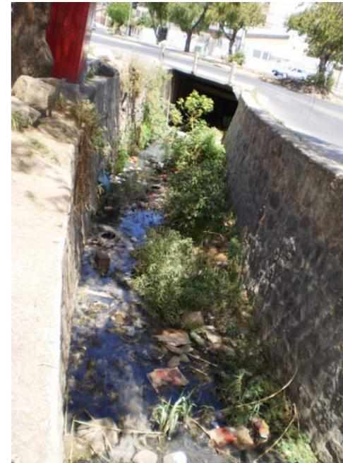
Torrenteras de la zona Norte. La falta de mantenimiento provoca la obstrucción del sistema.
