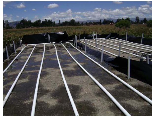
Una red de tuberías de diámetro 2" separadas entre sí unos 60 cm y con orificios de 8mm realizados en uno sólo de sus costados cada 60 cm serán las encargadas de distribuir el fluido a depurar sobre la
