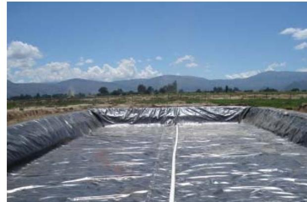
Colocaremos a continuación una membrana plástica de  $e=1$  mm que impida cualquier tipo de filtración de las aguas residuales hacia el terreno fuera del humedal.
