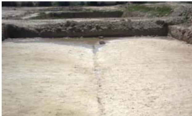
En cualquiera de los dos casos (ya sea excavación o relleno) será necesario realizar el allanamiento de la capa superior generando la inclinación necesaria para la colocación y adecuado funcionamiento de los drenes.
