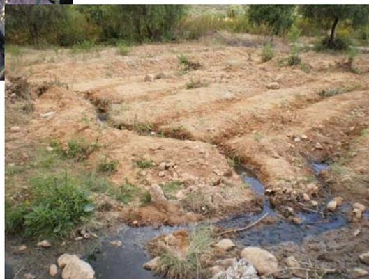
Fig.11. Red de infiltración al terreno. Solución transitoria
