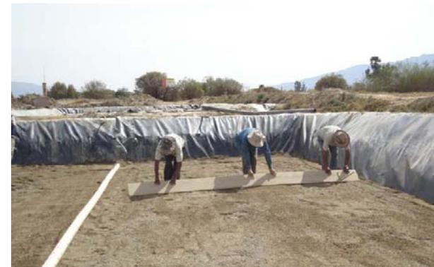
Sobre el plástico se extenderá la capa de material drenante formada por unos 15 cm de grava seleccionada de
