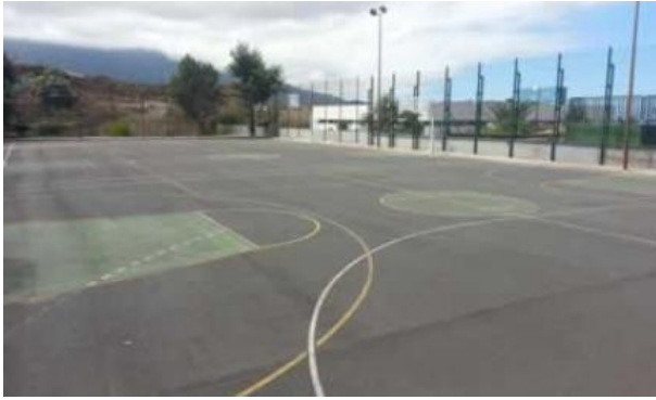
Nota. Pista deportiva exterior I.E.S. Mayorazgo
