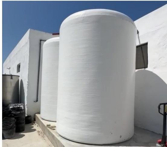
**Figura 5.4.** Tanques para almacenamiento del agua de lluvia.
