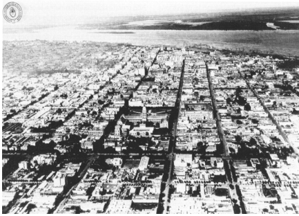
Figura V-13 Vista aérea a principios del siglo XX. Fuente: RIGOTTI, A. (2004). En “Diccionario de Arquitectura en la Argentina: estilos, obras, biografías, instituciones, ciudades.” Publicación de Diario de Arquitectura de Clarín.
