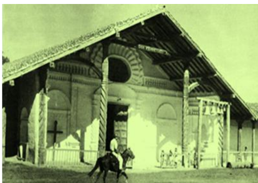
Fig. 2.56. Vista principal, iglesia de San Javier antes de la restauración
