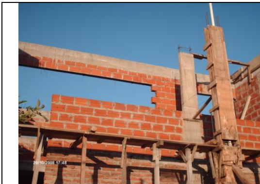
Fig. 2.73. Estructuras y muros de la vivienda
