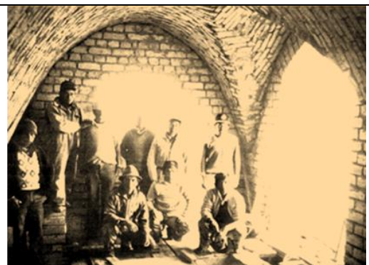
Fig. 2.51. Vista interior, obreros y bóveda
