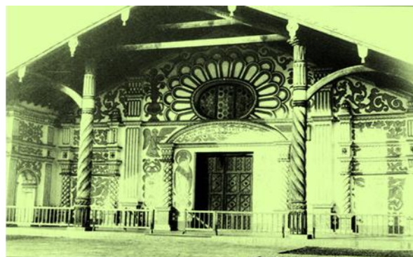
Fig. 2.57. Técnica en madera tallada después de la restauración
