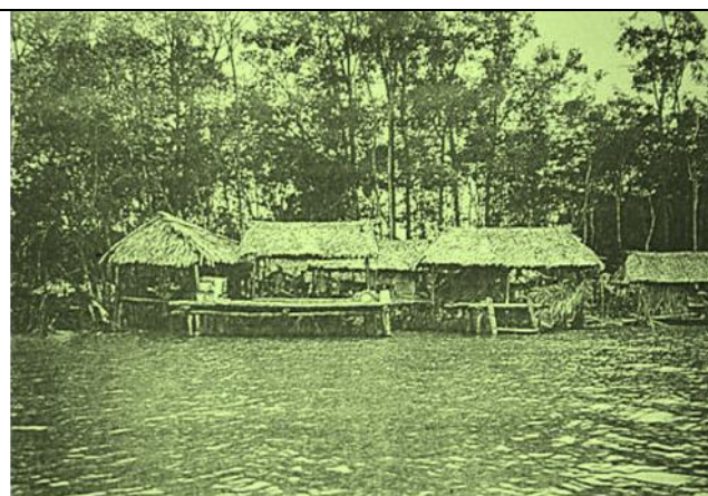
Fig. 2.15. Viviendas construidas sobre palafitos en Venezuela
