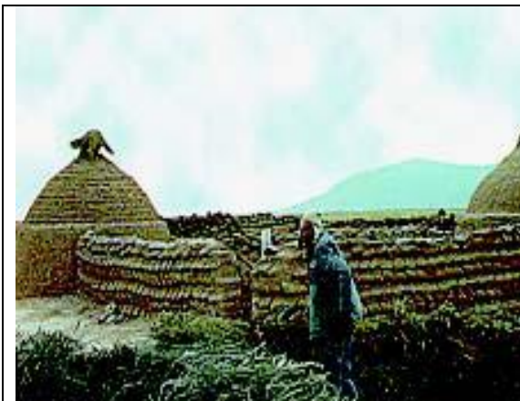
Fig. 2.52. Vivienda comunidad Urú Puquina, Oruro
