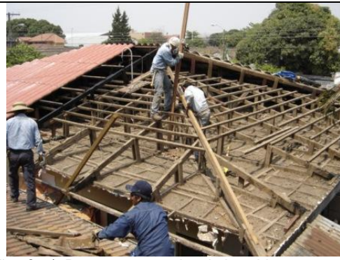
Fig. 2.74. Proceso constructivo de la cubierta con estructuras de maderas tipo sercha
