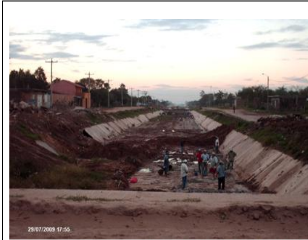
Fig. 4.7. Construcción del canal pluvial en la zona
