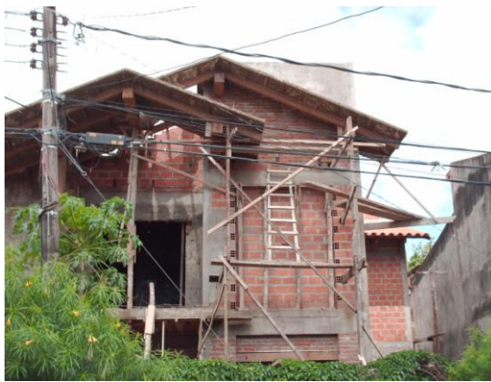
Fig. 2.75. Vivienda en la etapa de obra gruesa
