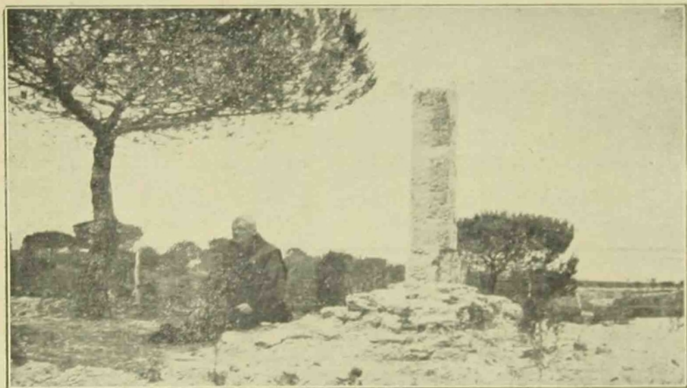
III. RESTOS SUBSISTENTES DE LA ANTIGUA LLAMADA CRUZ DE PIEDRA, A CORTA DISTANCIA DEL CONVENTO, CAMINO DE PALOS
