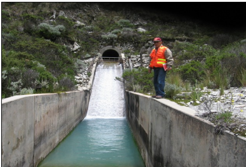
Figura N°70: Fotografía del canal efluente proveniente de la Laguna Parón para la hidroeléctrica del Cañón del Pato. Fuente: ANA, 2008.
