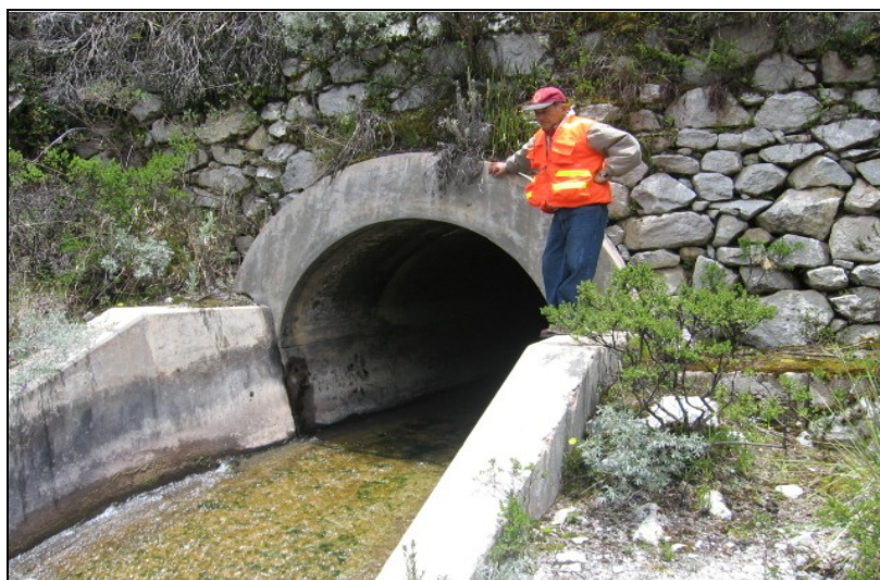
Figura N°71: Fotografía del canal efluente proveniente de la Laguna Parón para la hidroeléctrica del Cañón del Pato. Fuente: ANA, 2008.
