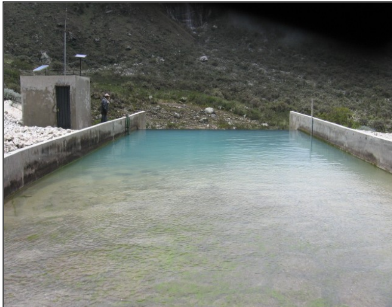
Figura N°72: Fotografía de canal efluente proveniente de la Laguna Parón para la hidroeléctrica del Cañón del Pato. Fuente: ANA, 2008.
