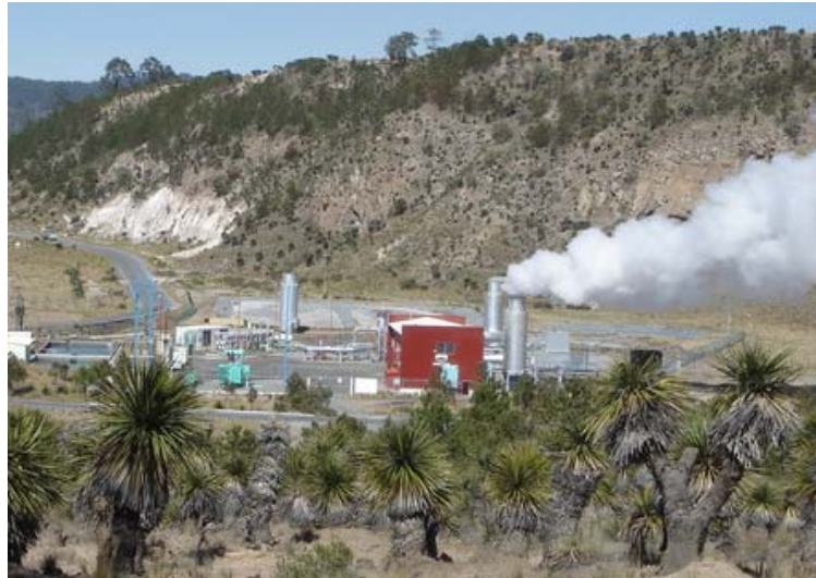
Figura 14. Vista de una planta (en total son ocho), en la Geotérmica “Los Humeros”.
