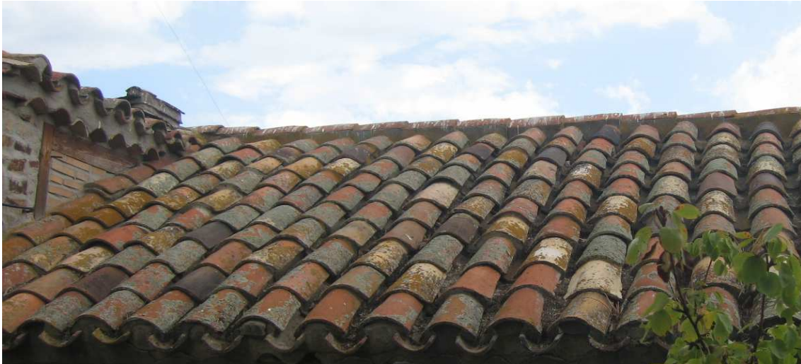
Figura 3: Tejado de la construcción primitiva.
