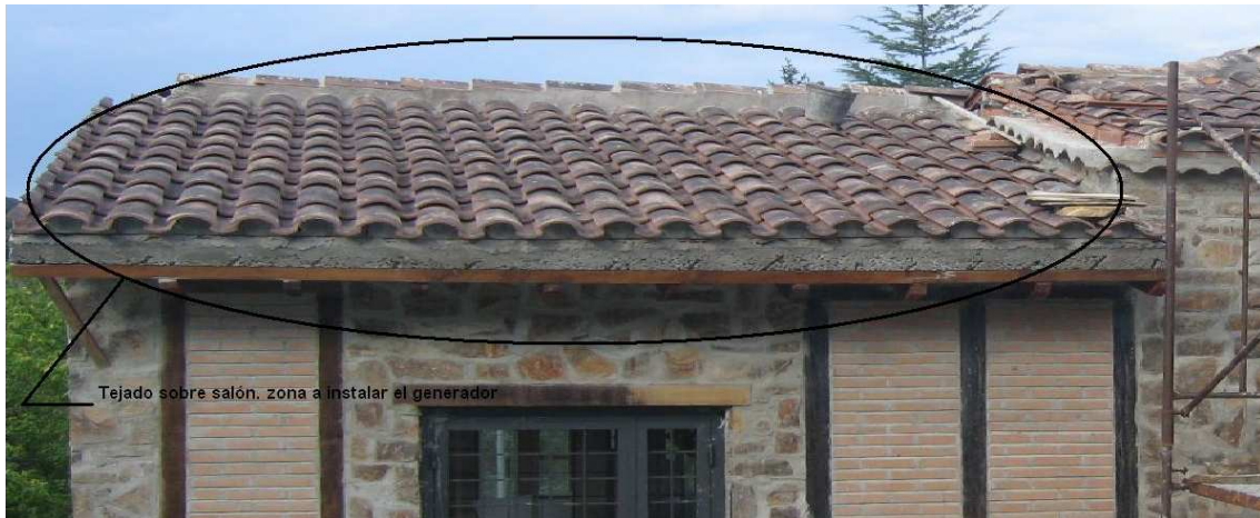
Figura 2: Detalle de la zona del tejado sobre el salón.
