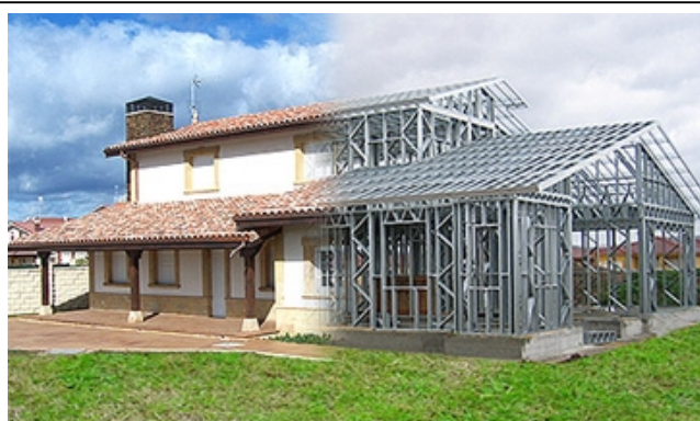
Ilustración 26 Casa con estructura en acero
