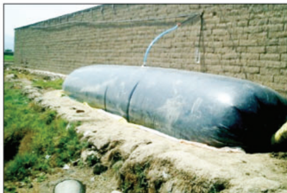
Foto 1. Bidigestor en funcionamiento.
