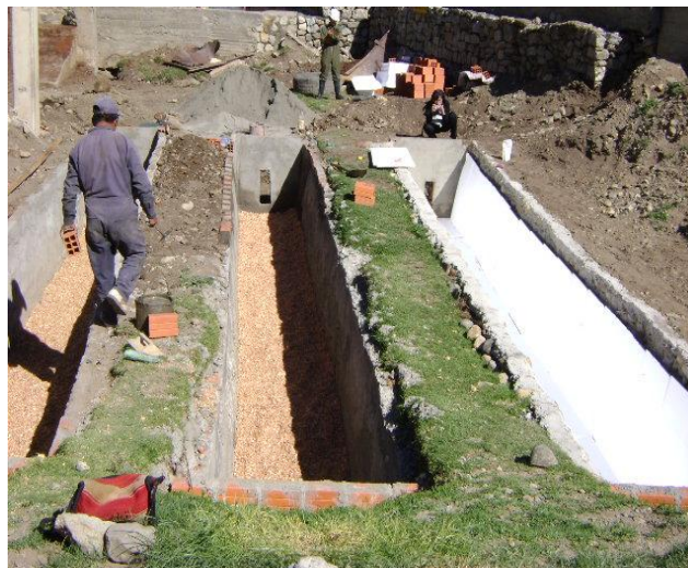
Figura 51. Emplazamiento de obras civiles.
