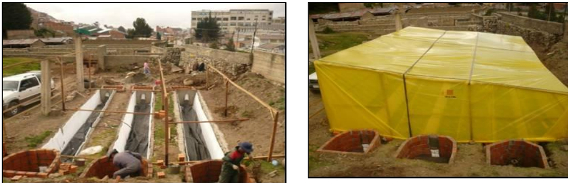
Figura 29. Instalación de sistemas de biodigestión Industrial (B1, B2 y B3).
