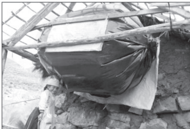
Foto 2. Reservorio de Biogás.
