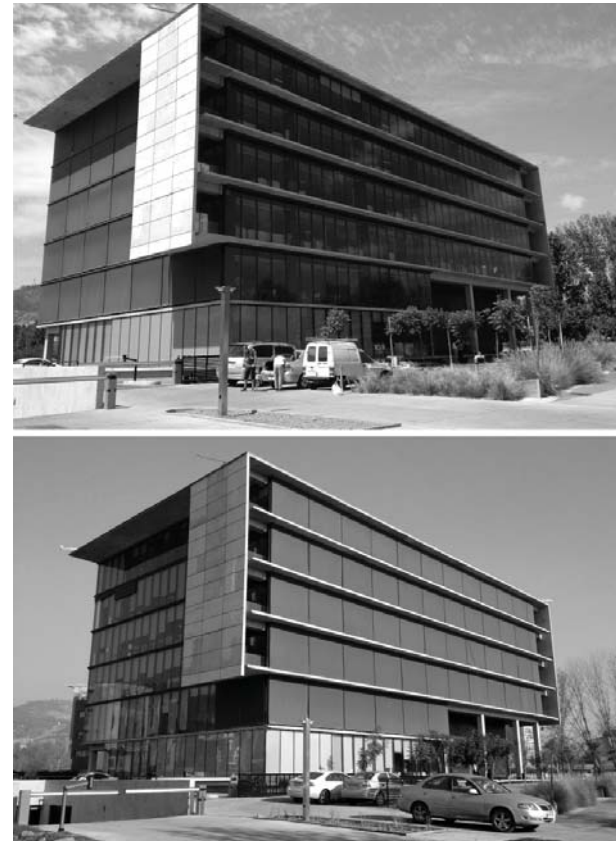
Imagen 4.6: Edificio tipo 2 con sus protecciones solares activadas en dos horas diferentes del día. Fuente: Elaboración propia
