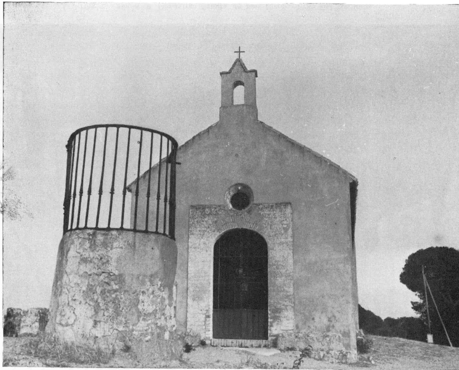
Fig. 2. Alcalá de Guadaira. Ermita de San Roque. Fachada principal y púlpito.
