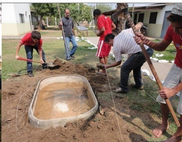
Figura 23: Jardinería - construcción de lago artificial.
