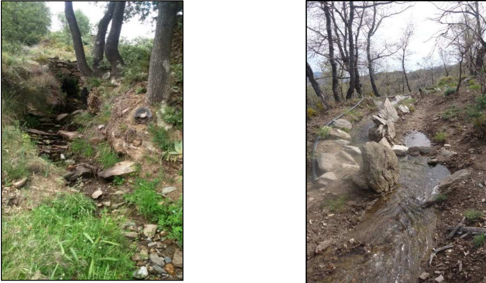
Figura 31: A la izquierda la acequia del miércoles, revestida de losa en el transcurso de un salto de agua. A la derecha la acequia de Barjas en el lugar donde se parte su caudal con el injerto de la Higuera del Cerromán.
