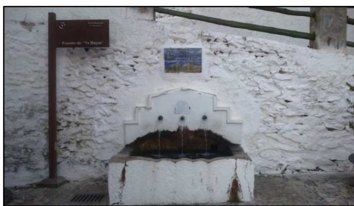
Figura 34: Fuente Ya bajo con los tres caños funcionando.
