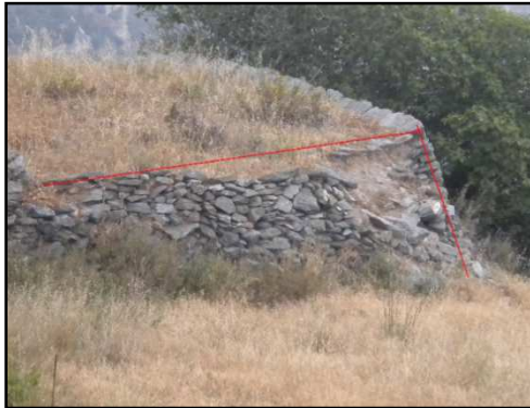
Figura 46: A la izquierda era rematada con balate de piedra parcialmente derrumbado y a la derecha haza rematada en pendiente de tierra. En rojo están marcados los perfiles.
