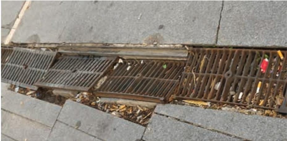
Fig 17. Estado de un tramo de rejillas sin señalar.
