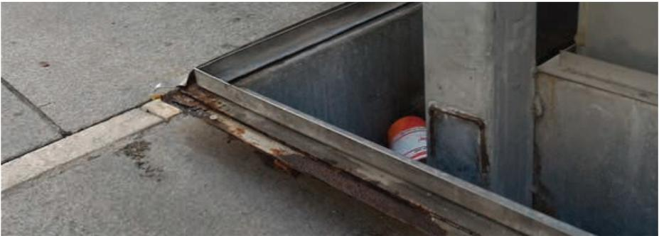
Fig 28. El soporte de los cristales se ha convertido por falta de mantenimiento en un saliente peligroso
