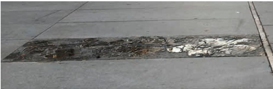
Fig . mal estado del pavimento
