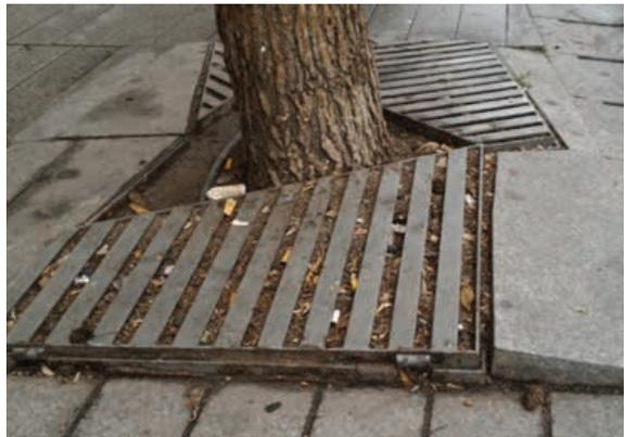
Fig 18 y 19. Alcorques difíciles de localizar y con mal mantenimiento
