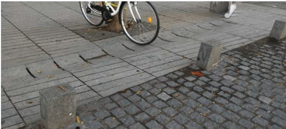
Fig 32. Bolardos de piedra de difícil detección
