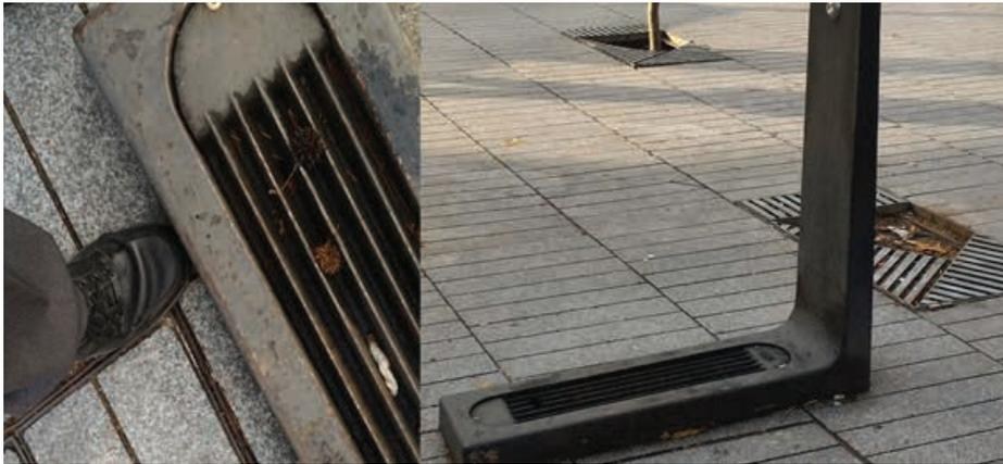
Fig 29. Elementos separadores en mal estado
