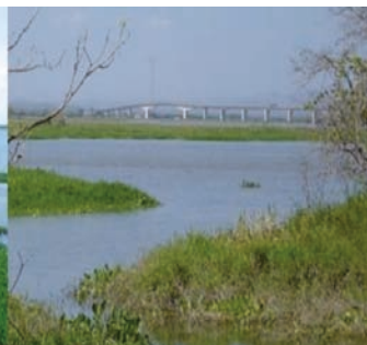
Vista del Puente
