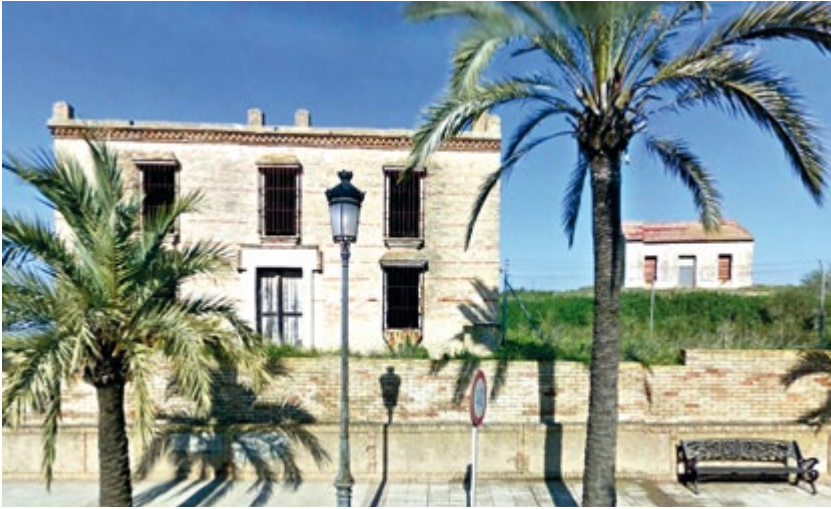
Vista general actual de “Villa Argentina” desde la Avenida de América. En primer plano “Hogar Buenos Aires” construido hacia 1922, al fondo “Casa Argentina”, fundada e inaugurada por Enrique Martínez Ituño en 1909.
