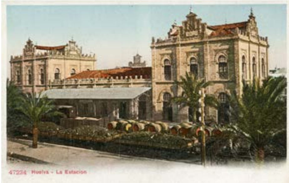
Imagen 4.42. Estación de Ferrocarril de M.Z.A. TP 1903./ Col. Autor
