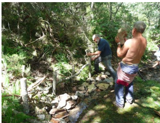
Foto: Restauración de la Fuente de Valdordoz
