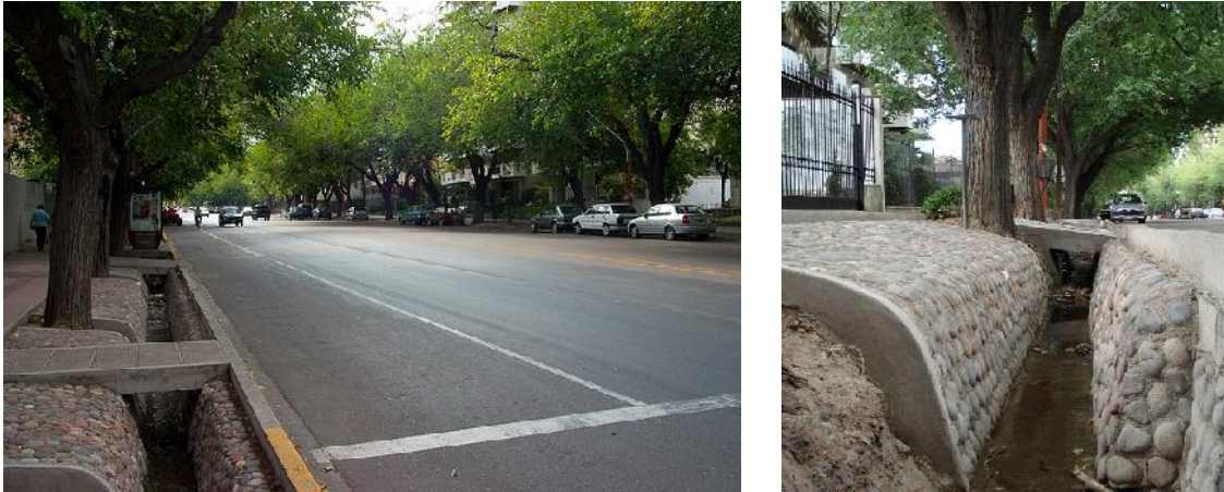
Fig. 29a y b: Sistema hídrico (acequias) que riegan el arbolado urbano. Fuente: Flickr.com
