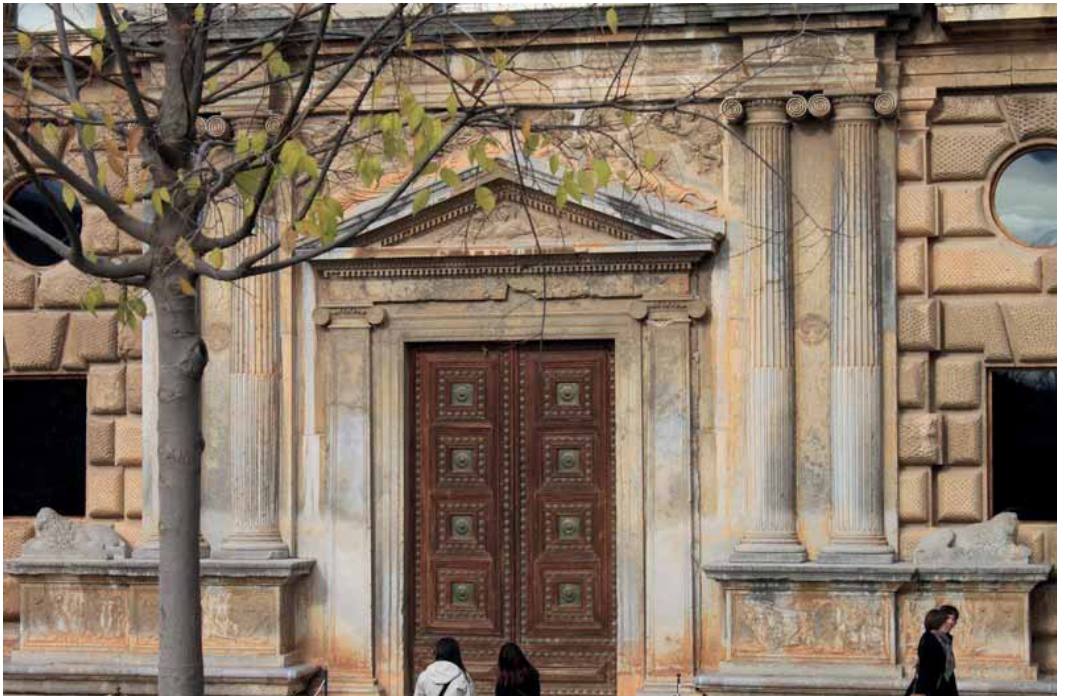
Fig. 22. Alhambra, palazzo di Carlo V, fronte meridionale, portale
