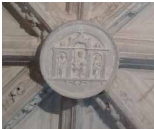
Fig. 32. Clave del apeadero del ayuntamiento de Sevilla (foto gentileza de Carlos Plaza).
