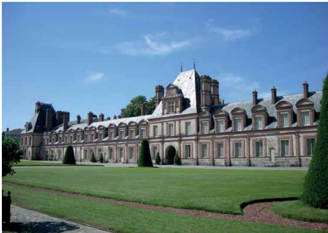
Fig. 11. Sebastiano Serlio (?), facciata settentrionale della grande basse Cour del Castello di Fontainebleau
