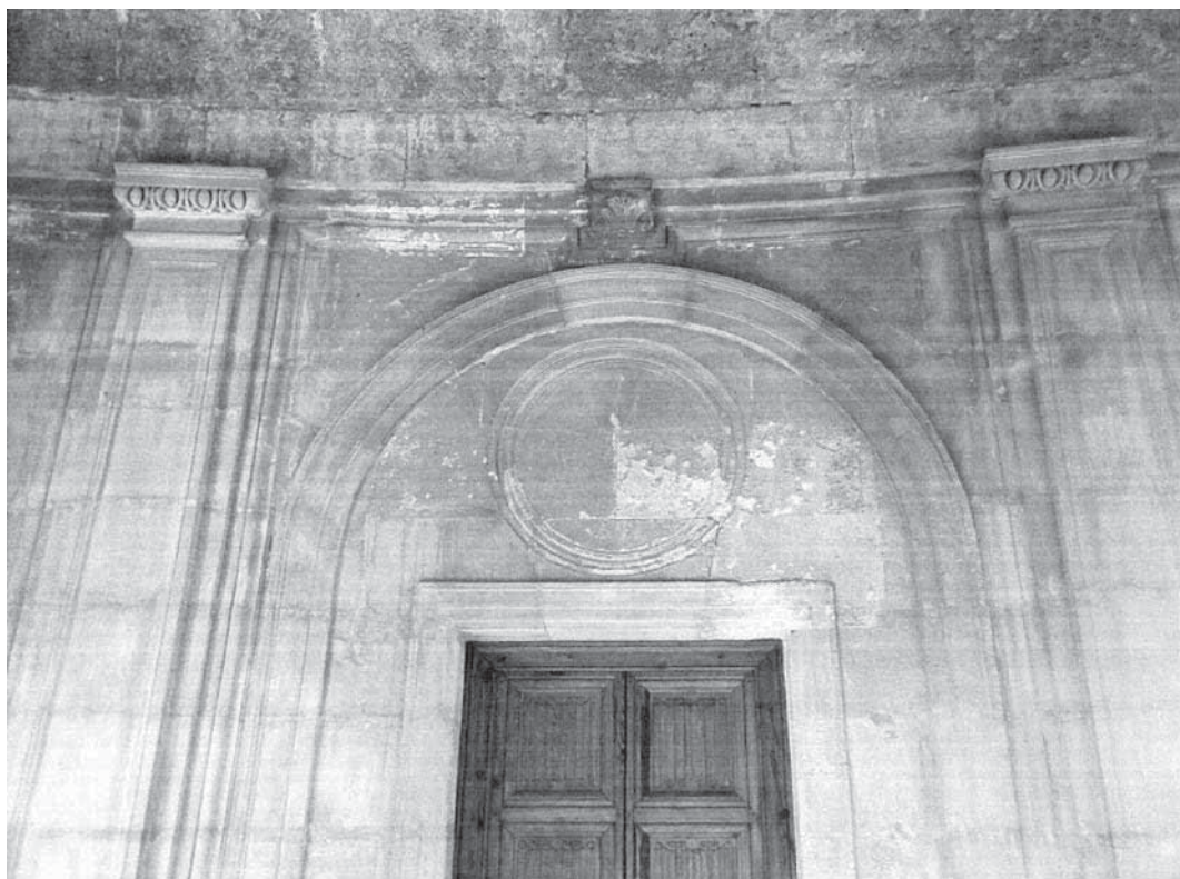
Fig. 11. Detalle del patio: se añaden pilastras de Cesariano, molduras de Siloé.
