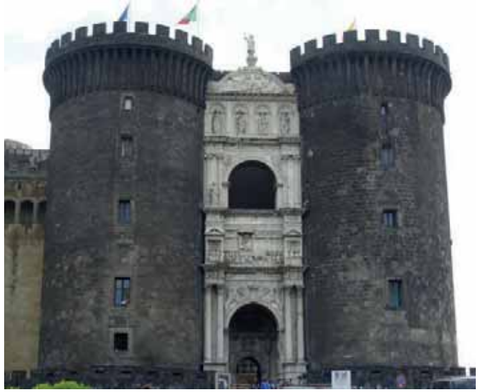
Fig. 27. Napoli, Castelnuovo, Arco del re Alfonso
