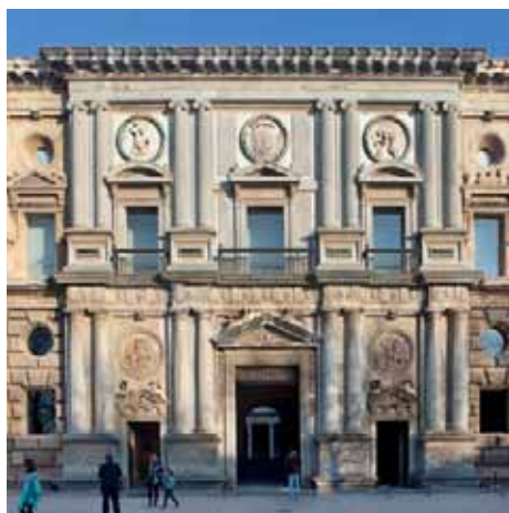
Fig. 9 a) Palazzo di Carlo V, motivo centrale dell'ala occidentale
