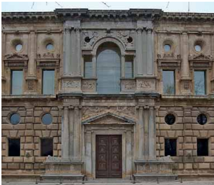
Fig. 7. Palazzo di Carlo V, motivo centrale dell'ala meridionale
